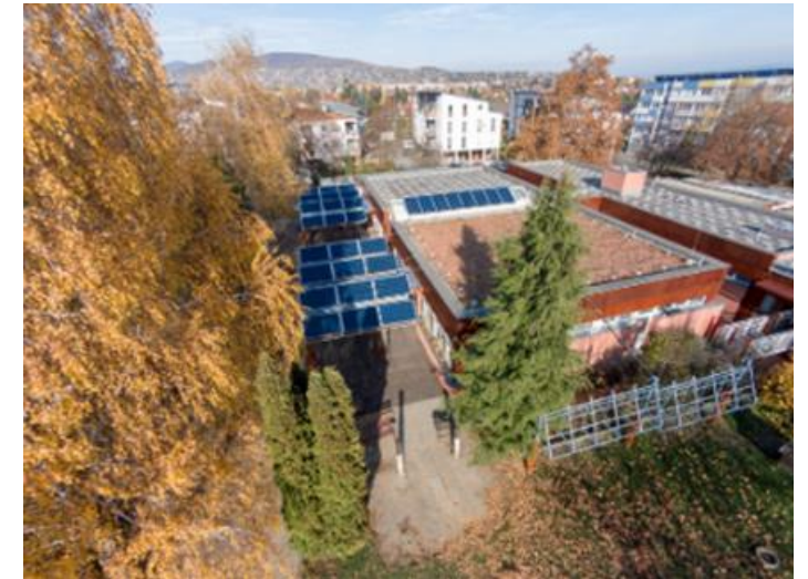
Püspökmajor Óvoda a felújítás után, @PIME'S Concerto project
