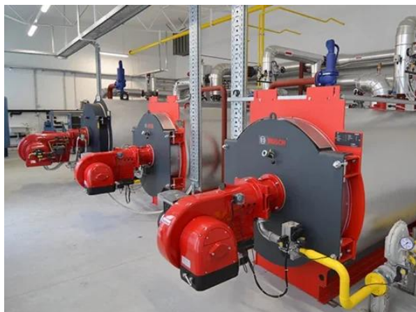
Picture 42.: Boiler room in Šorlijevo naselje
