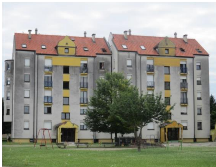
Stavba Engelsova ulica 42 - 44
