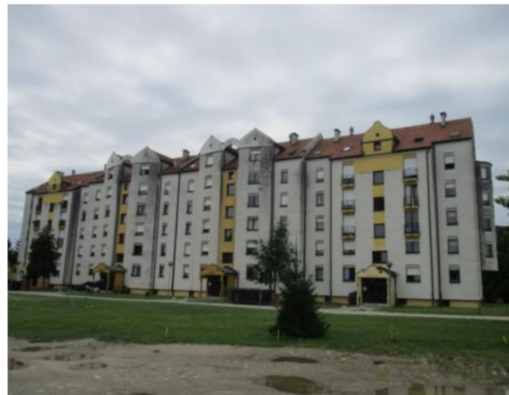
Stavba Engelsova ulica 46 - 52
